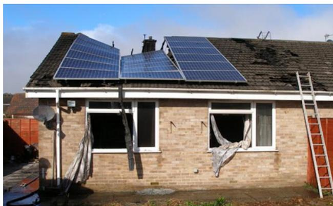
Рис. 2 - Обрушение крыши с фотоэлектрическим оборудованием во время пожара
