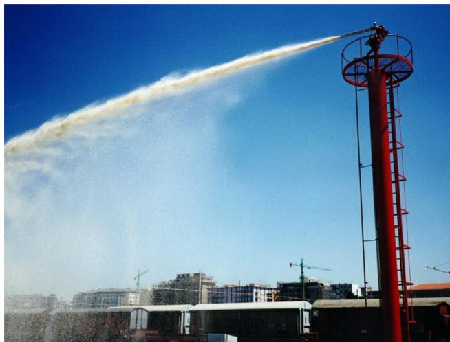
Рисунок 1 – Подача ОТВ из лафетного ствола на объекте защиты
