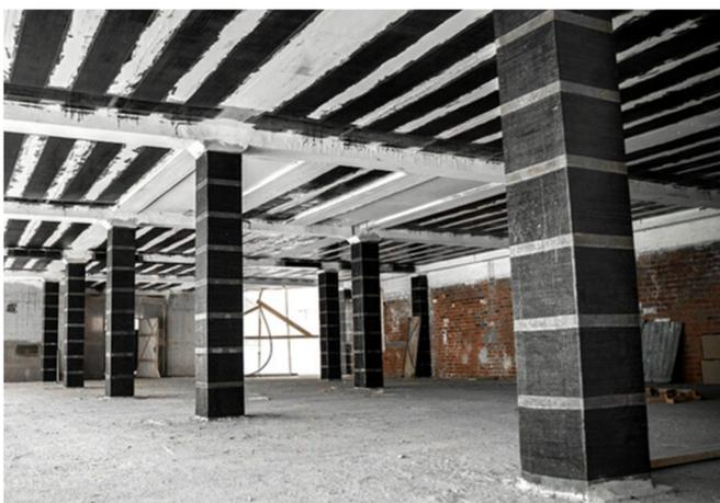
Рис. 9. Внешнее армирование железобетона композитными материалами
