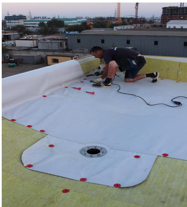
Рисунок 1 – ПВХ мембрана для кровли
