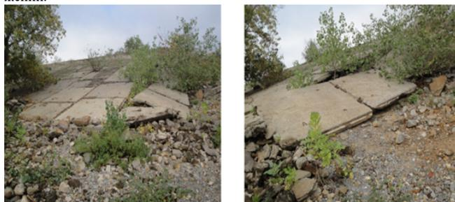
Рис. 3. Смещение плит защитных сооружений от проектного положения
