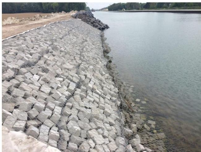
Рис. 2. Применение габионных конструкций
